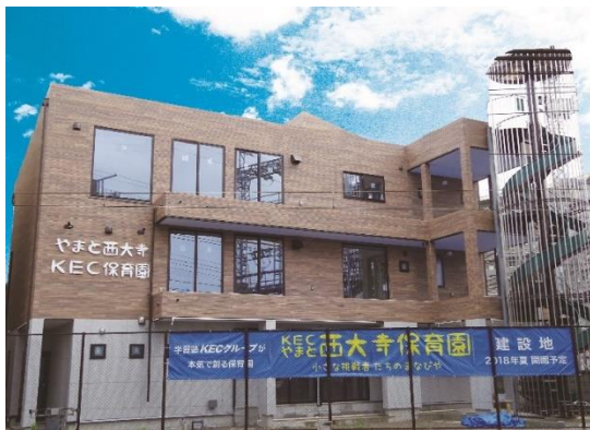
屋上から滑り台が！やまと西大寺KEC保育園
