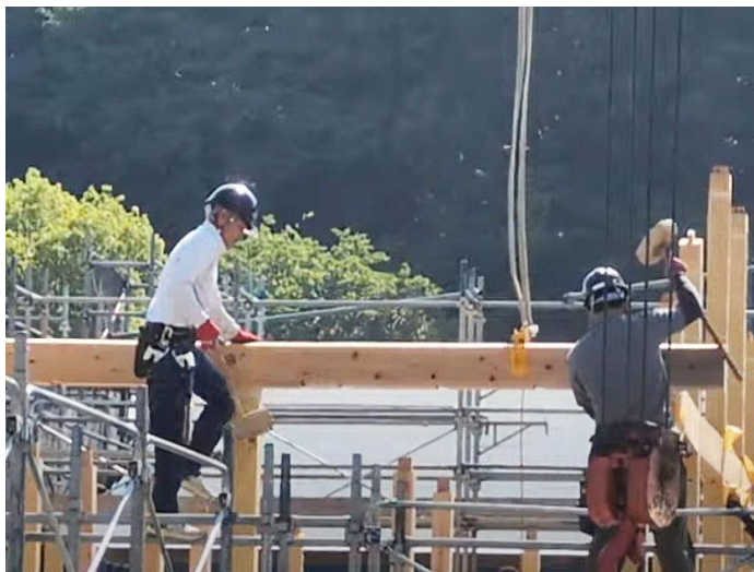
建設中の写真
