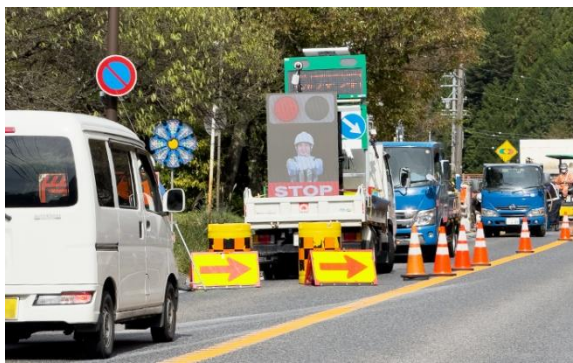
AI 警備システムを導入した工事現場
